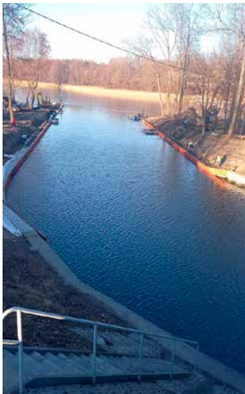
► Remont Kanału Piękna Góra trwał niespełna rok, od września 2021 r., do kwietnia br.
