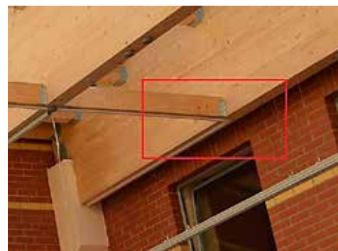
► Błąd modelowania płatwi stanowiącej część drewnianej konstrukcji nośnej (po lewej). Rzeczywisty wygląd połączenia płatwi z dźwigarem (po prawej)
