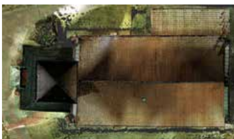
► Widok dachu kościoła
