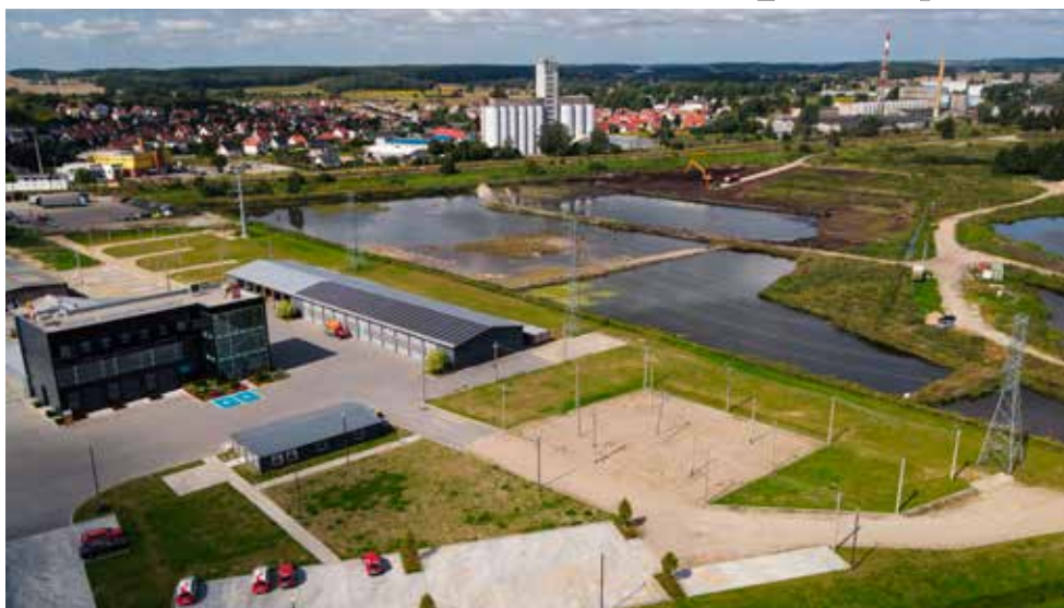
► Na ponad dwóch hektarach terenu powstał trzykondygnacyjny obiekt szkoleniowy, poligon do ćwiczeń prowadzenia prac pod napięciem oraz plac manewrowo-szkoleniowy. Projekt dofinansowany z środków UE w ramach Programu Operacyjnego Polska Wschodnia 2014-2020
