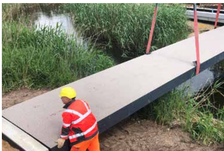
► Montaż kładki w Wielbarku. Przęsło o rozpiętości 15 m i szerokości 2 m, masa 4,5 t.
