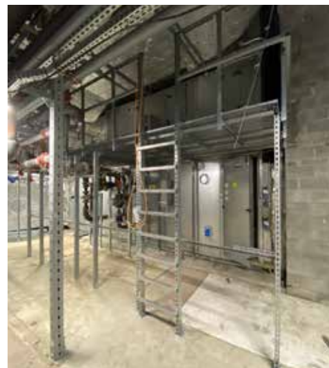
► Konstrukcja podestu – widok od przodu
