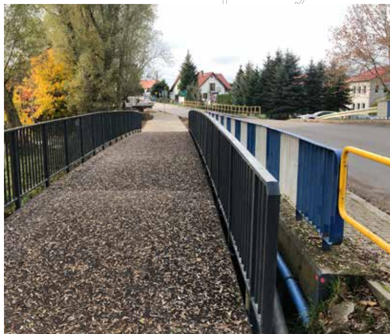
► Jedna z najnowszych w regionie realizacji w technologii InfraCore®Inside – trzyprzęsłowa kładka w Bartągu.
