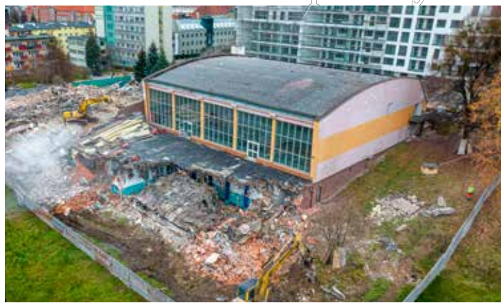
► Widok całej inwestycji na etapie prac rozbiórkowych.
