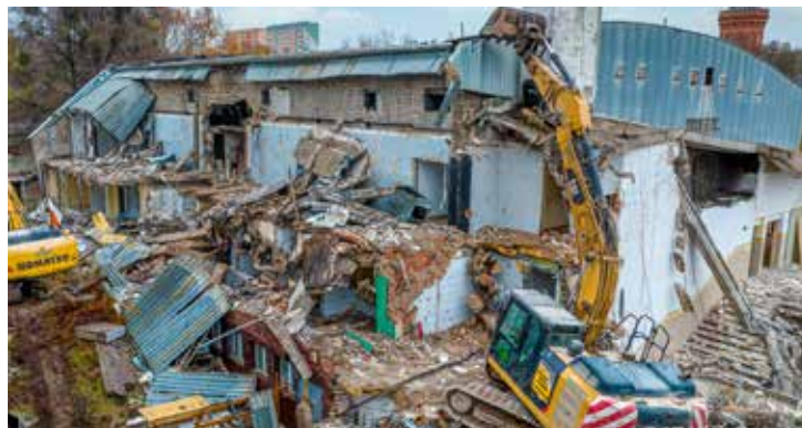
► Wszystkie materiały z rozbiórki były sortowane i oddawane do odpowiednich firm zajmujących się utylizacją, zgodnie z ustawą o odpadach.
