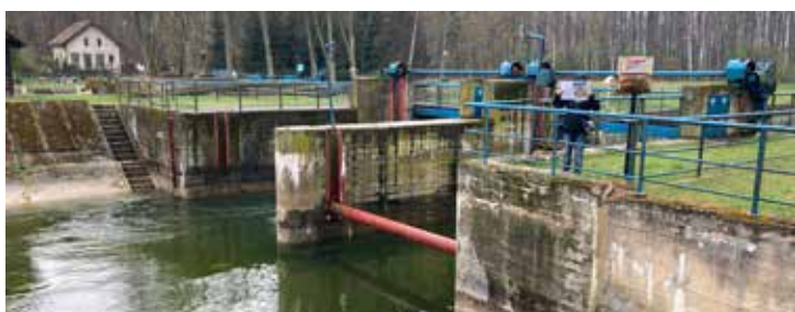
► Widok jazu przez remontem.
