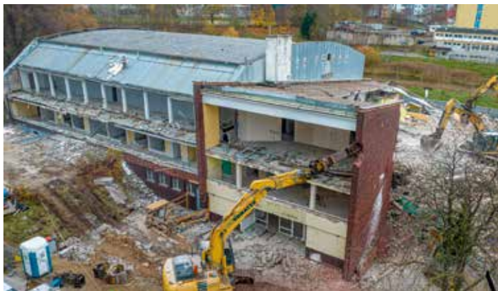
► Główne roboty wyburzeniowe „realizowały” cztery koparki, które w jeden dzień rozebrały główną bryłę budynku.
