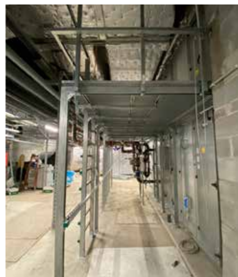
► Konstrukcja podestu – widok z boku
