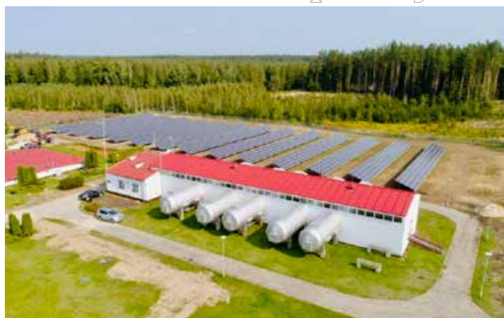
► Wewnętrzna instalacja fotowoltaiczna zasilająca Stację Uzdatniania Wody Miasta Elku w Przykopcach dotarła do finału w kategorii ochrona środowiska
